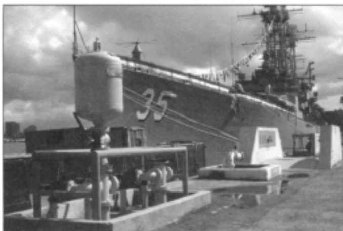
吸收装载燃料时由于油泵启动和停机而产生的冲击
