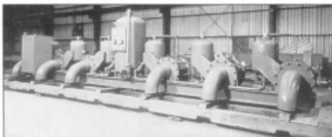
吸收由于大流量阀门关闭而产生的冲击
